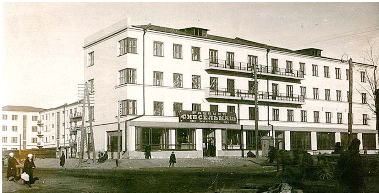
Рис. 1. Жилой комбинат для рабочих обозного завода, 1931–1932 гг. (инженер С. М. Игнатович, архитектор П. И. Русинов 7 )
