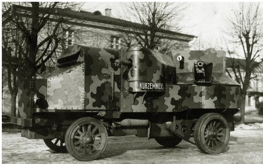
Рис. 3. Тяжёлый пушечно-пулемётный броневомобиль «Гарфорд»
