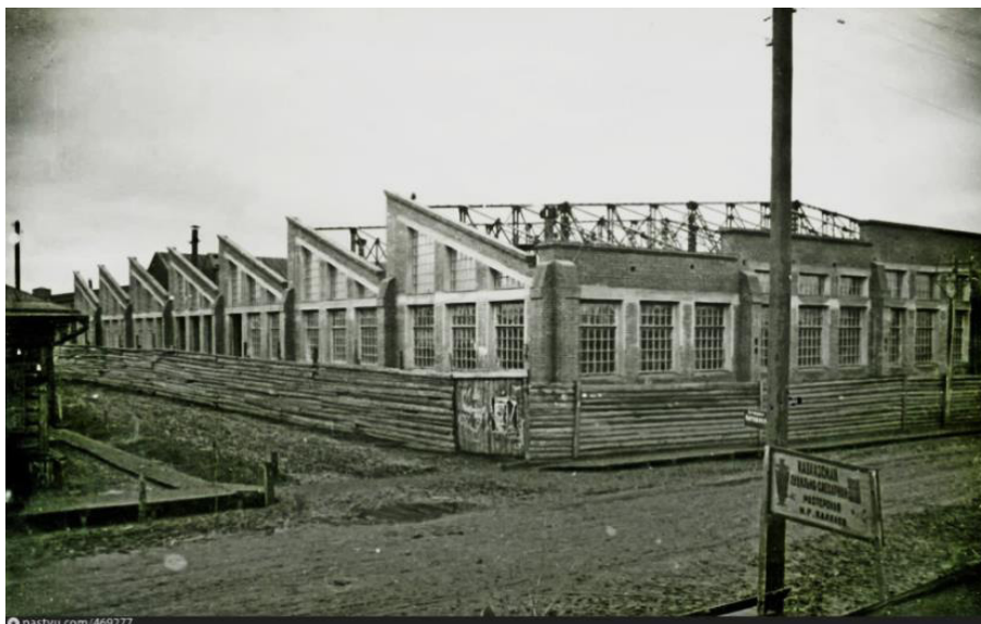
Рис. 6. Омск. Завод «Красный пахарь». Строительство кузнечно-прессового цеха. Арх.-инж. П. П. Голышев, инж. Бродский, Арцимович, Краузе. Фото из фондов Омского государственного историко-краеведческого музея, 1930
